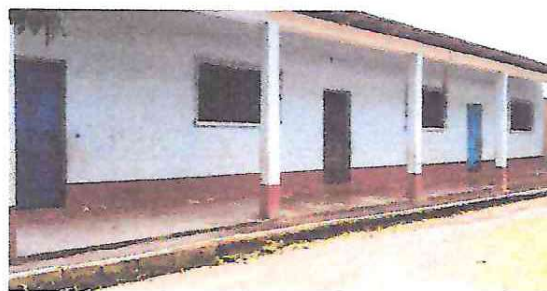
FOTO 8: Fabricación e instalación de ventanas de U pvc del modulo 1
