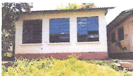
FOTO 9: Fabricación e instalación de balcones para ventanas del modulo 3
