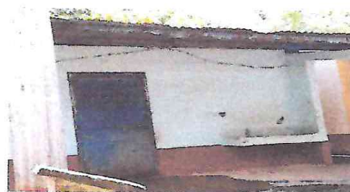
FOTO 6: Mantenimiento de puerta de baño sanitario, lijado, cepillado a dos mano con pintura anticorrosiva.
