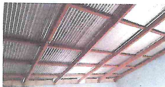
FOTO 2: Cambio de soporte de madera por Costaneras 4x2 legitimo del modulo 1
