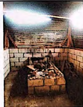
ESTUFA: improvisada ya deteriorada sin plancha ni chimenea
