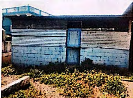
COCINA: pequeña improvisada sin ventanas y con media pared y techo de láminas deteriorada.
