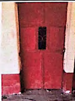
PUERTAS: Manteniimiento de 9 puertas lijada cepillada y pintada a dos manos con pintura anticorrosiva.
