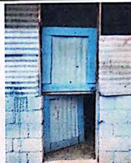
Puerta de cocina: sustitucion por puerta de metal
