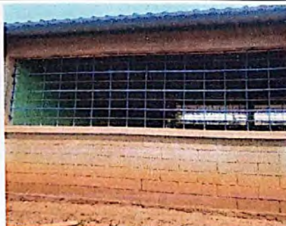
VENTANAS: solo rejas tiene, instalacion de ventanas
