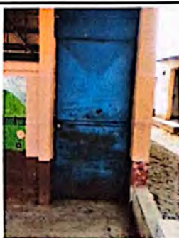
PUERTAS: Manteniimiento de 9 puertas lijada cepillada y pintada a dos manos con pintura anticorrosiva.
