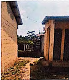
ESPACIO DISPONIBLE PARA INSTALAR DOS SANITARIOS
