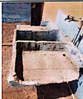
Pila sustitucion de dos lavaderos
