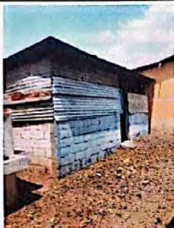
Cocina Escolar: mantenimiento y ampliacion
