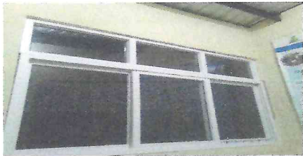
Ventanas colocadas en las aulas
