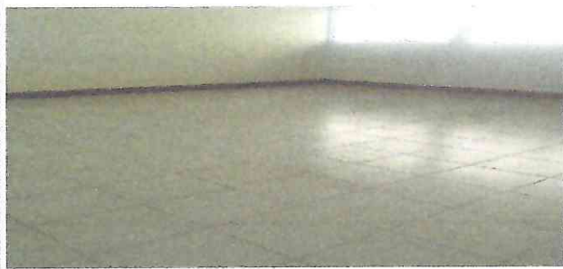
Colocacion de pisos terminado en las aulas
