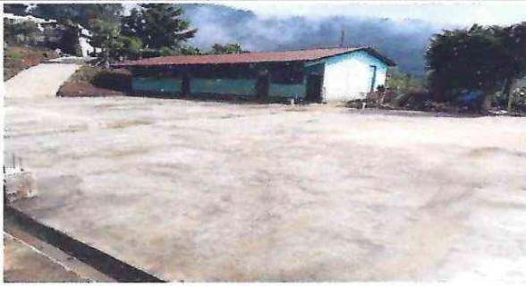
Foto 1: Losa de patio
