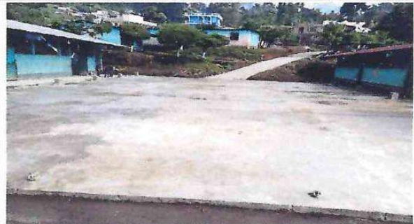
Foto 2: Losa de patio
