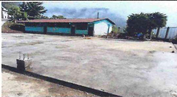
Foto 3: Losa de patio
