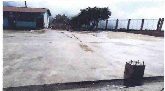
Foto 4: Losa de patio
