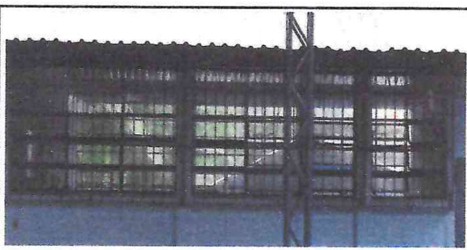
Foto 6: Colocación de balcones en módulo 2 y 3.
