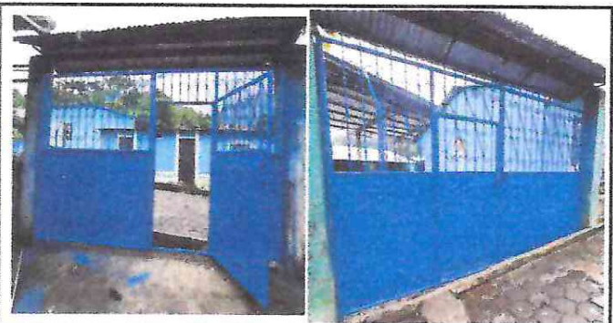
Foto 5: Mantenimiento de portón principal.
