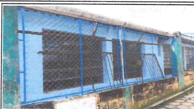
Foto 2: Cambio de malla perimetral.
