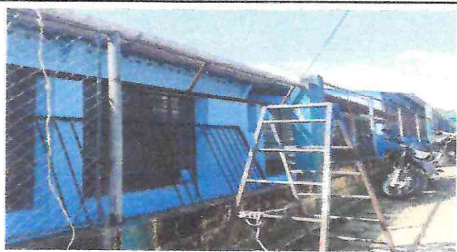
Foto 3: Cambio de estructura de soporte de metal.
