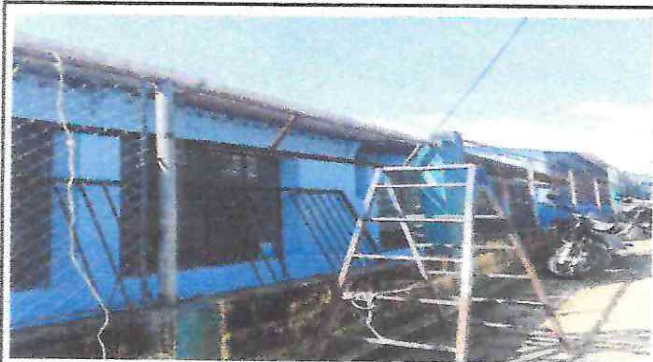
Foto 3: Cambio de estructura de soporte de metal.
