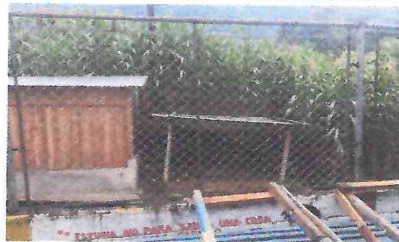
Foto 2: Cambio de malla perimetral.
