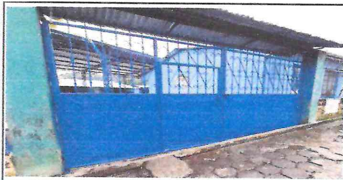
Foto 5: Mantenimiento de portón principal.
