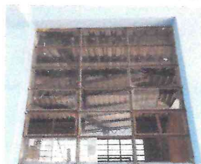
Foto 4: Cambio de vidrios de ventanas de las aulas.
