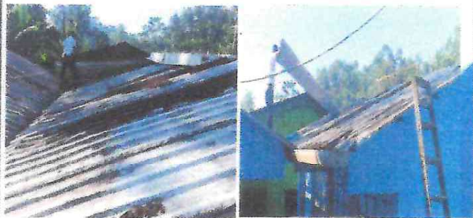
Foto 1: Cambio de techado de aulas y cambio de capotes en módulo 4.
