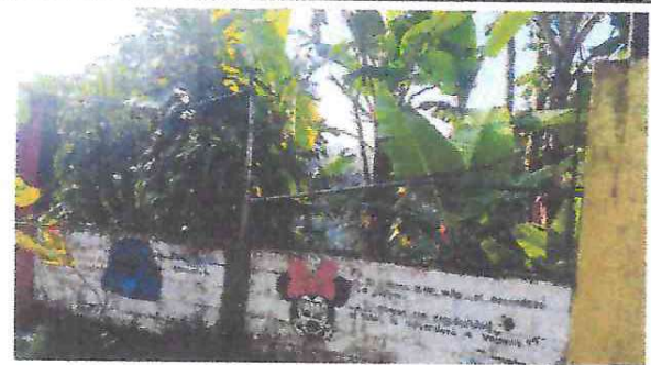
Foto 2: Cambio de malla perimetral.
