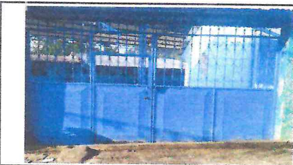
Foto 5: Mantenimiento de portón principal.
