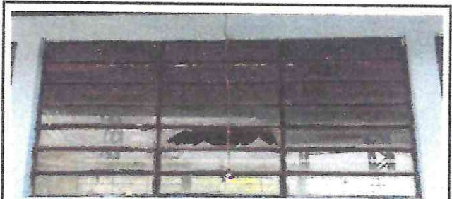
Foto 6: Colocación de balcones en módulo 2 y 3
