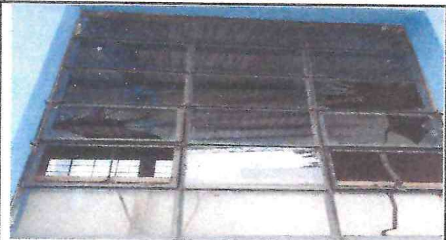
Foto 4: Cambio de vidrios de las ventanas de las aulas.
