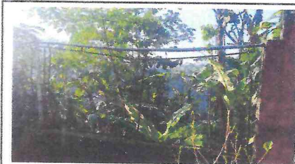
Foto 3: Cambio de estructura de soporte de metal.
