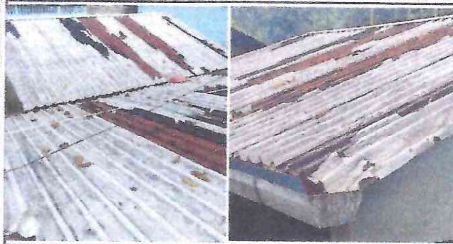
Foto 1: Cambio de techado de aulas y cambio de capotes en módulo 4.
