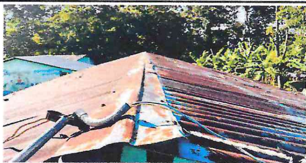
Foto 1: Cambio de techado y cambio de capotes del modulo 1 dirección y aulas.
