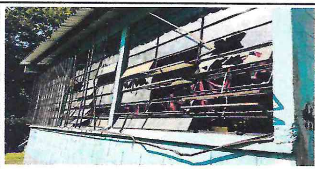
Foto 6: Cambio de balcones en el modulo 1.
