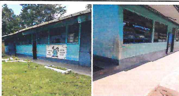
Foto 4: Pintada completa de todo el modulo 1 y modulo 2.
