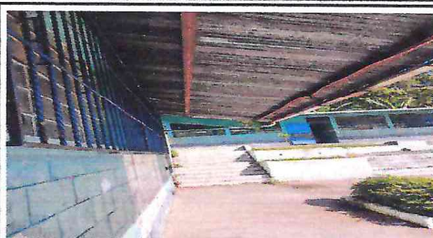
Foto 2: Mantenimiento de estructura de soporte de metal
