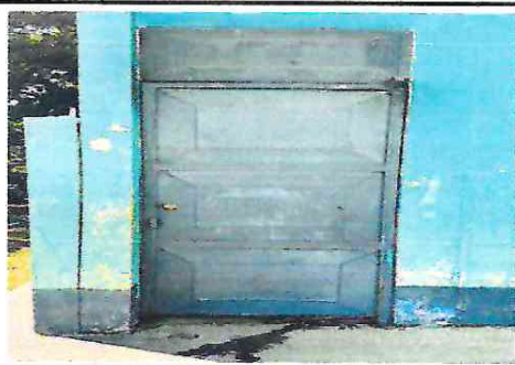
Foto 5: Cambio de puertas del modulo 1.
