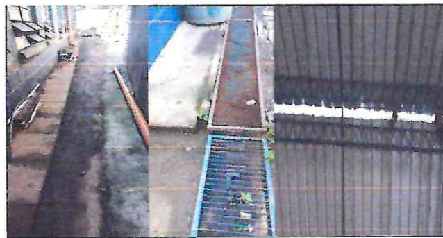
Foto 6: Cunetas y láminas
