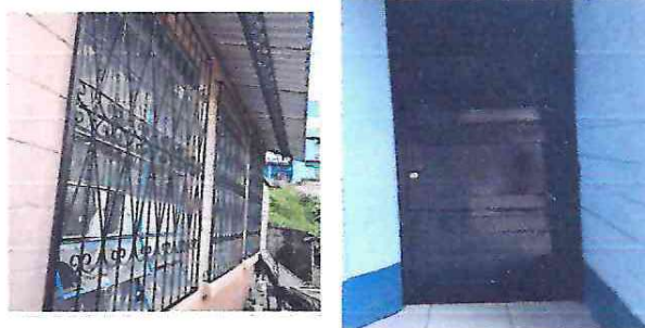
Foto 4 Sustitución de balcones y puerta
