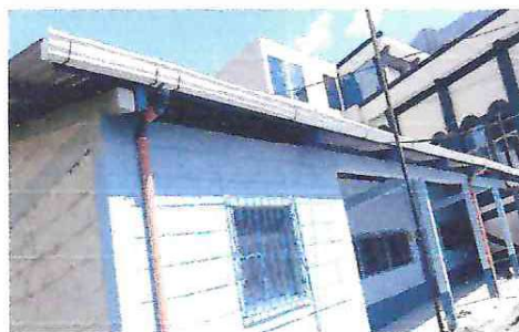
Foto 6 Canales y bajadas pluviales
