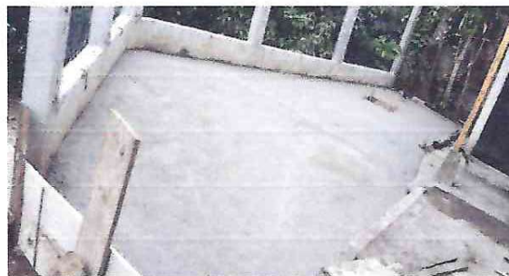
Foto 2 Losa de patio
