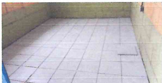
Foto 1 Cambio de piso de cemento liquido por ceramico
