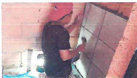
Foto 2. Sustitución de piso por Azulejos
