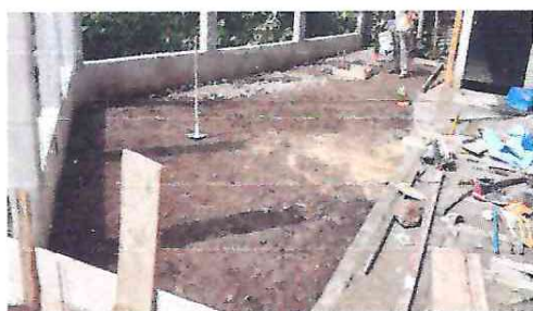
Foto 3. Losa de patio
