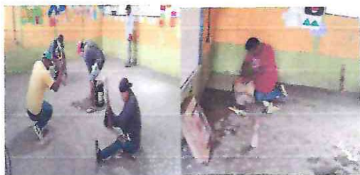
Foto 1. Sustitución de piso por cerámico
