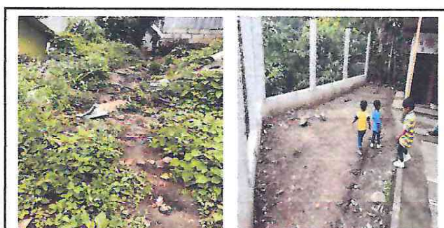
Foto 6. reparación de drenaje y losa de patio
