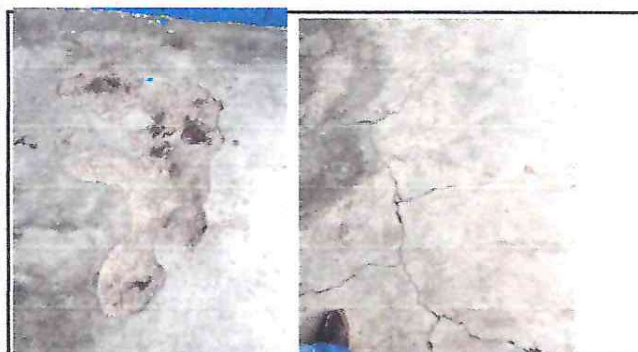
Foto 3 Sustitución de piso de cemento liquido por ceramico, aulas y corredor
