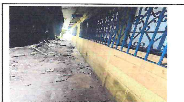
Foto 4 Sustitución de canales pluviales adelante y atrás de las aulas
