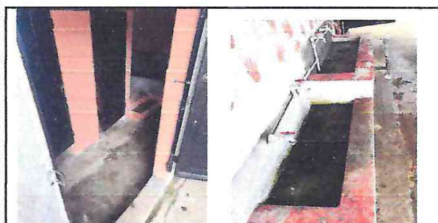
Foto 5 Sustitución de piso de cemento liquido por azulejos argentinas
