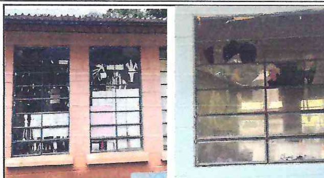
Foto 2. Sustitución de balcones
