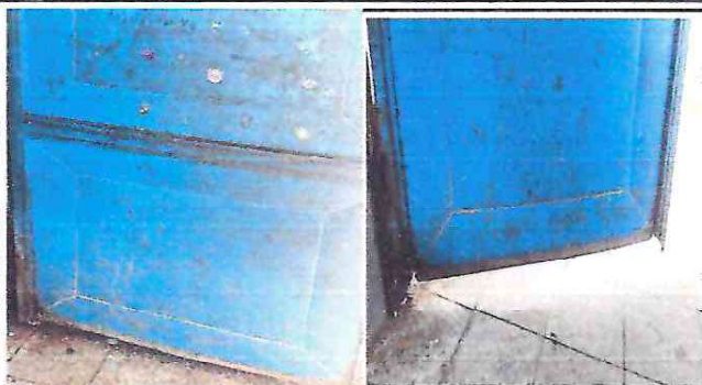
Foto 1. sustitución de puerta en dos aulas
