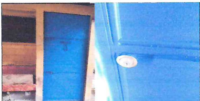
MANTENIMIENTOS DE PUERTAS, LIJADO Y APLICACIÓN DE PINTURA
