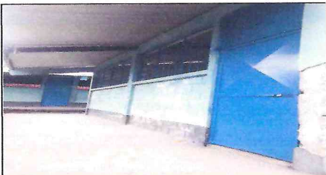
SUSTITUCION DE VIDRIOS
