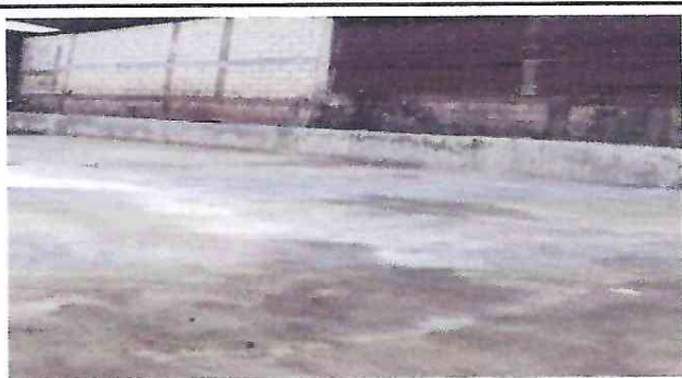
LOSA DE PATIO
