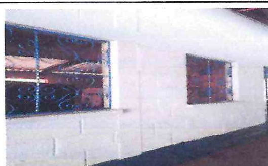
FOTO 6 COLOCACION DE BALCONES
