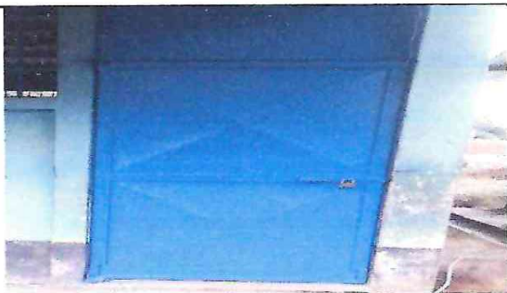
FOTO 5 MANTENIMIENTO DE PUERTAS LIJADO Y APLICACIÓN DE PINTURA
