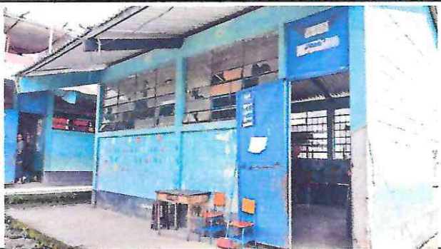
SUSTITUCION DE VIDRIOS A BALCONES
