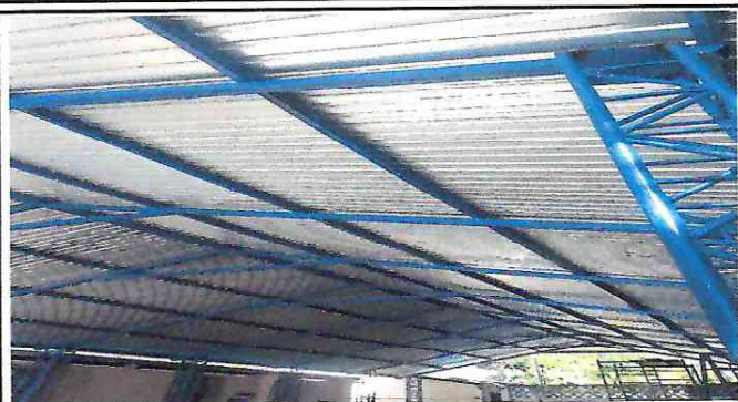
Foto 1: Colocación de cubierta de lámina en el patio de la escuela
