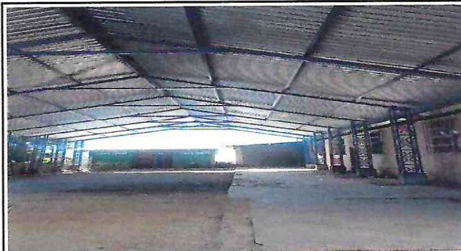
Foto 2: Colocación de estructura de techo en el patio de la escuela.
