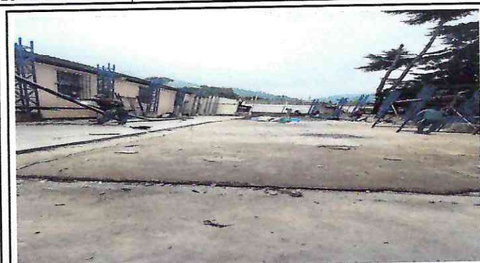
Foto 1: Colocación de estructura de techo en patio de la escuela.
