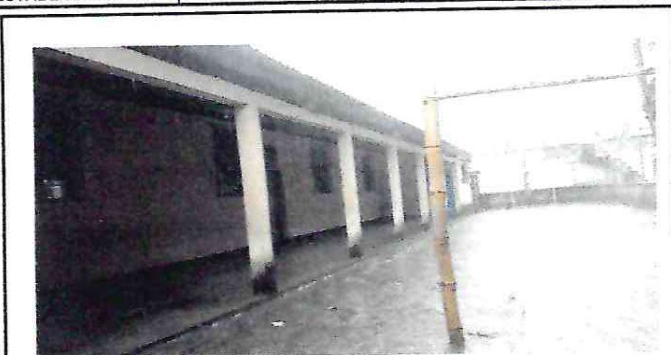
Foto 1. Colocación de lámina y estructuración de techo en patio de la escuela.
