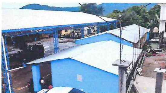
foto 1: Cambio de techado y capotes del aula de preprimaria por lamina troquelada aluzinc calibre 26
