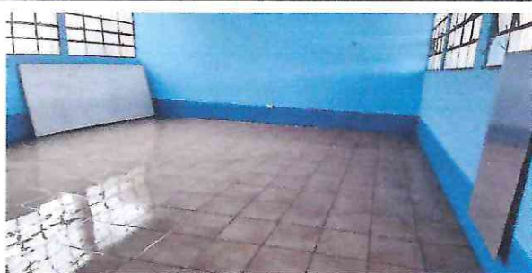
foto 5: Sustitucion de torta de piso concreto a piso de granito de aulas modulo 3
