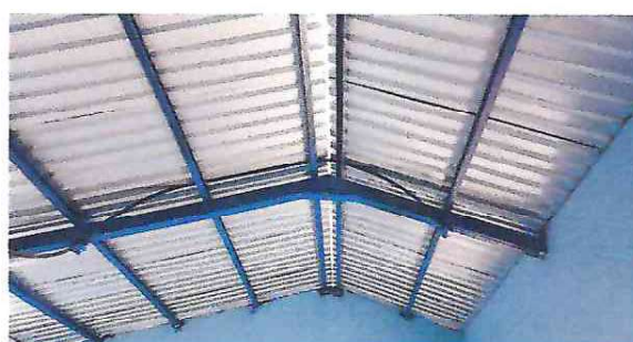
foto 2: Mantenimiento de estructura de soporte de metal
