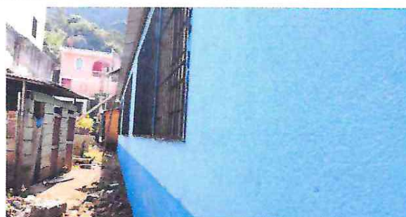
foto 4: colocacion de balcones de atrás de las aulas del modulo 3
