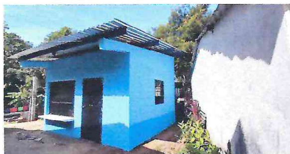
foto 8: cambio de lamina de cocina por lamina troquelada aluzinc calibre 26 y mantenimiento de base metalica
