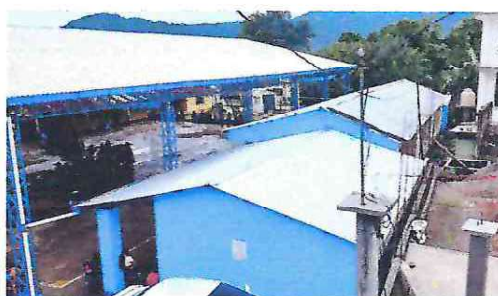
foto 6: Colocacion de canales pluviales del aula de preprimaria
