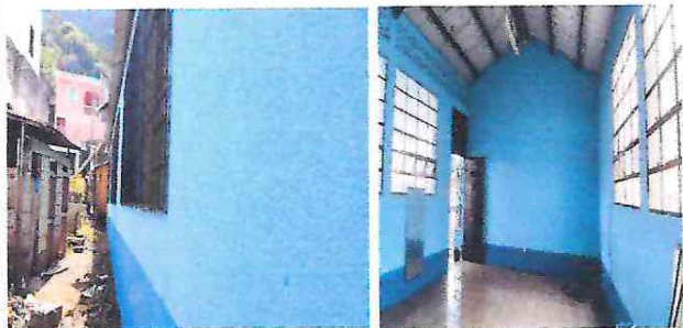
foto 7: pintura en muros exteriores e interiores del modulo 3
