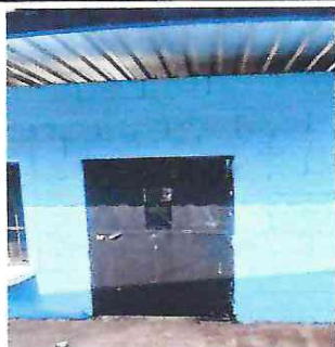
foto 9: Sustitucion de puerta de metal de la cocina
