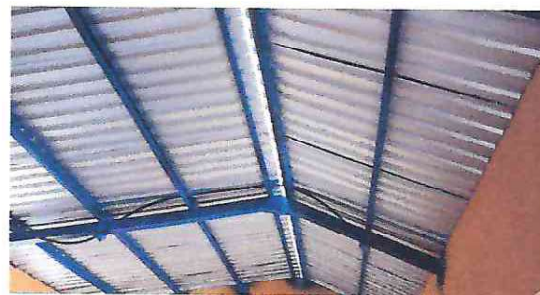
foto 2: Mantenimiento de estructura de soporte de metal
