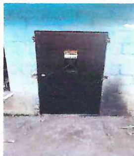
foto 9: Sustitucion de puerta de metal de la cocina
