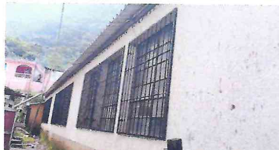
foto 4; colocacion de balcones de atrás de las aulas del modulo 3
