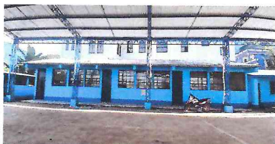
FOTO 3: mantenimiento de puertas del modulo 3
