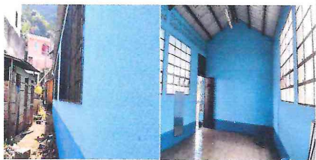
foto 7: pintura en muros exteriores e interiores del modulo 3
