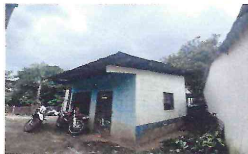
foto 8: cambio de lamina de cocina por lamina troquelada aluzinc calibre 26 y mantenimiento de base metalica
