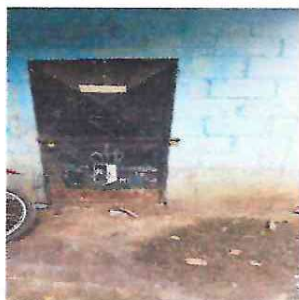
foto 9: Sustitucion de puerta de metal de la cocina
