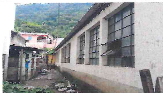
foto 4; colocacion de balcones de atrás de las aulas del modulo 3
