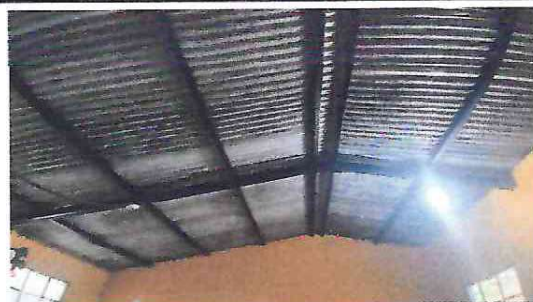
foto 2: Mantenimiento de estructura de soporte de metal
