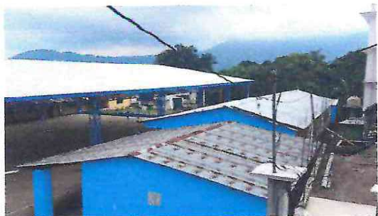
foto 1: Cambio de techado y capotes del aula de preprimaria por lamina troquelada aluzinc calibre 26
