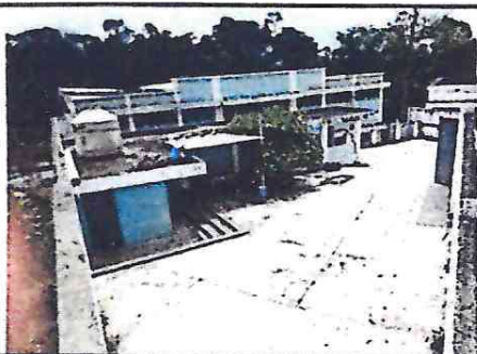
Foto 3: Instalación de Razor en muro perimetral sin seguridad pared norte y oeste.
