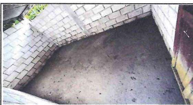
Foto 4: Fundición del área de cocina.
