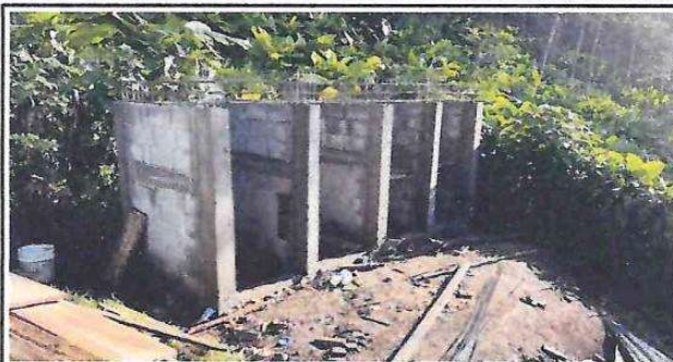
Foto 1: Servicios sanitarios y sus accesorios en proceso.
