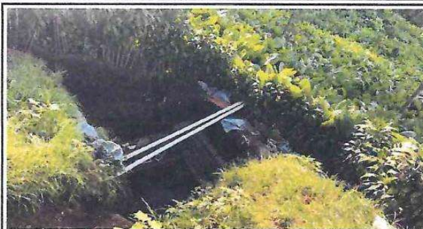
Foto 2: Fosa séptica en proceso.
