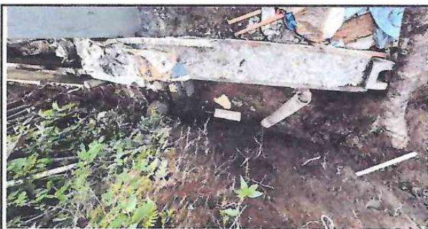
Foto 6: Cuneta en proceso.
