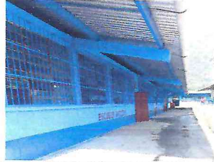
Foto 2. Balcones para ventanas
