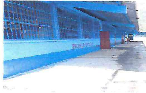
Foto 4. Pinturas en muro interior y exterior
