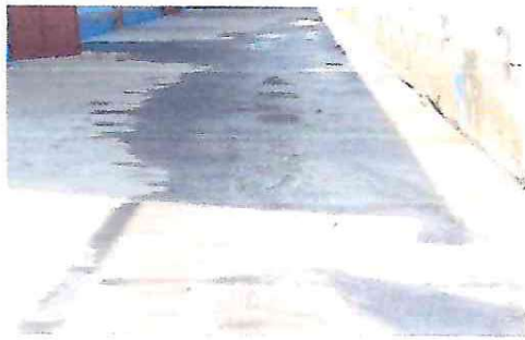
Foto 3. Cuneta de concreto
