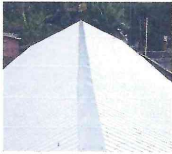
Foto 1. Cubierta de lamina
