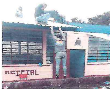
Foto 1 Cubierta de laminas
