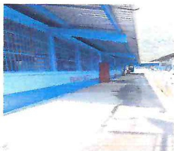
Foto 3 Cuneta de concreto
