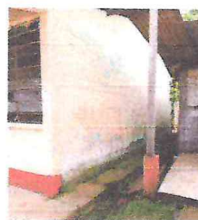
FOTO 4: PINTURA EN MUROS INTERIOR Y EXTERIOR.
