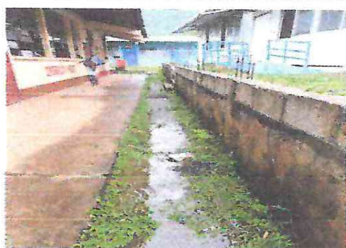
FOTO 3: CUNETAS DE CONCRETO.
