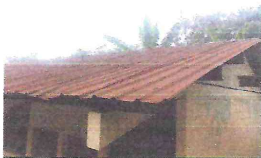
FOTO 1: CUBIERTA DE LAMINA.
