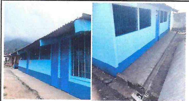
Foto 2: Sustitucion de vidrios y sustitucion de balcones de metal
