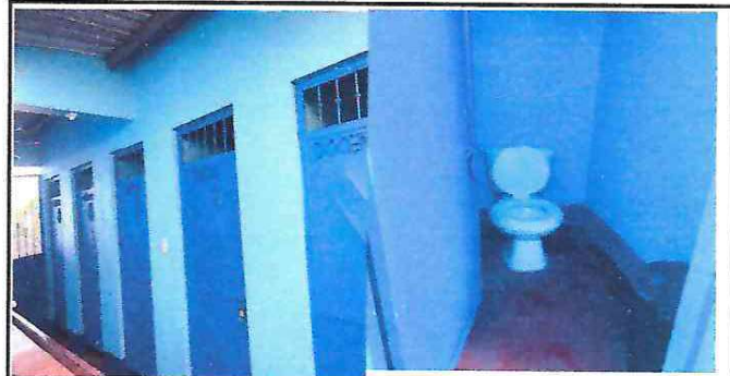
Foto 4: Sustitucion de accesorios de inodoro
