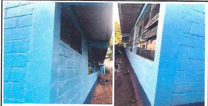
Foto 6: Reparacion de repello y cernido de paredes
