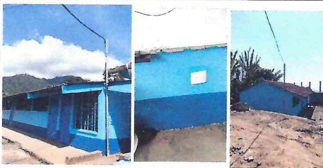
Foto 5: Reparacion de sistema Electrico
