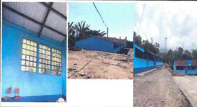
Foto 3: Pintura en muro exteriores y interiores
