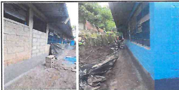
Foto 6: Reparacion de repello y cernido de pared
