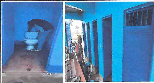
Foto 4: Sustitucion de accesorios de inodoro
