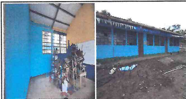
Foto 3: Pintura en muros exteriores y interiores
