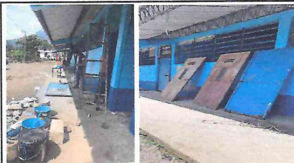
Foto 1: Mantenimiento a estructura de metal puerta
