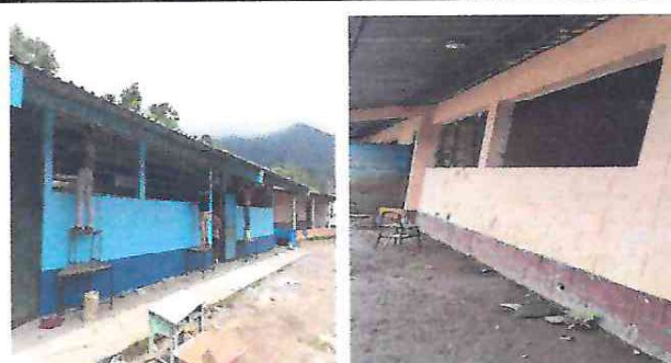
Foto 2: Sustitucion de vidrios y Sustitucion de balcones de metal
