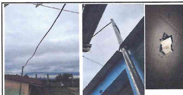
Foto 5: Reparación del sietema electrico
