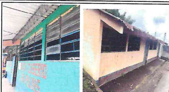
Foto 2: susuticion de vidrios y susticion de balcones de metal.
