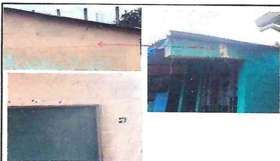
Foto 5: Reparacion de sisitema electrico
