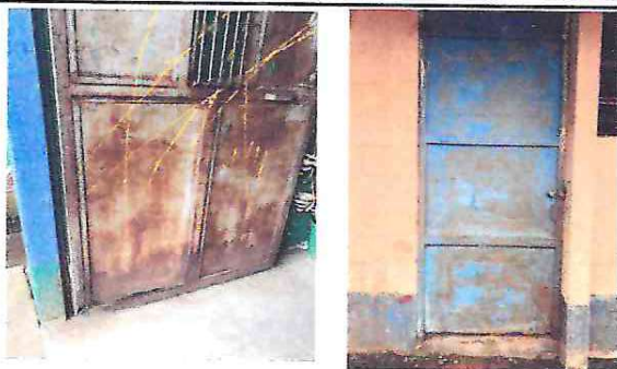
Foto 1: Mantenimiento a estructura de metal puerta.
