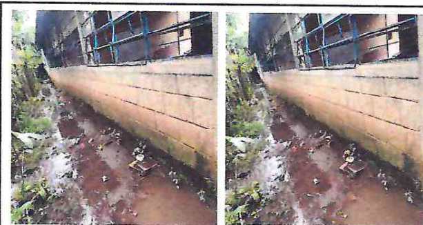
Foto 6: Reparación de repello y cernido de paredes.
