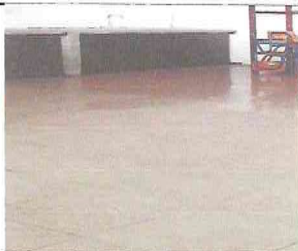
Foto 3: Colocación de pisos cerámico
