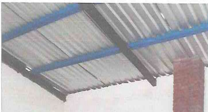
Foto 3: cubierta de lamina
