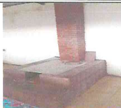
Foto 2: Mantenimiento de estufas
