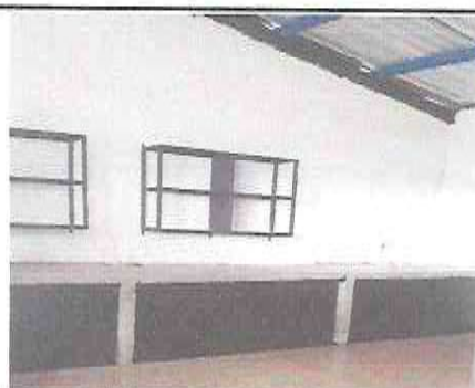
No.5 cernido de paredes
