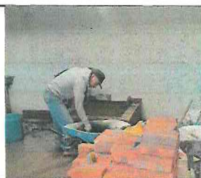
No 6.reparacion de estufa
