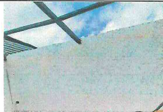
Foto 3: cubierta de lamina
