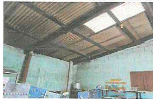
Foto 4: cubierta de lamina
