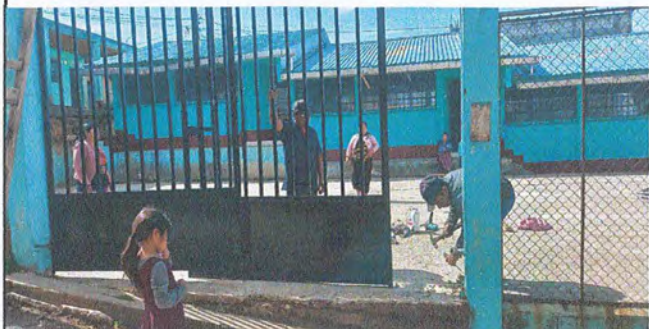
Foto 1: Colocacion del porton
