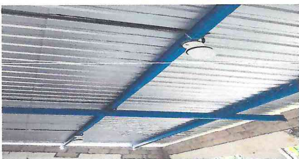
Foto 5. Mantenimiento de energía eléctrica
