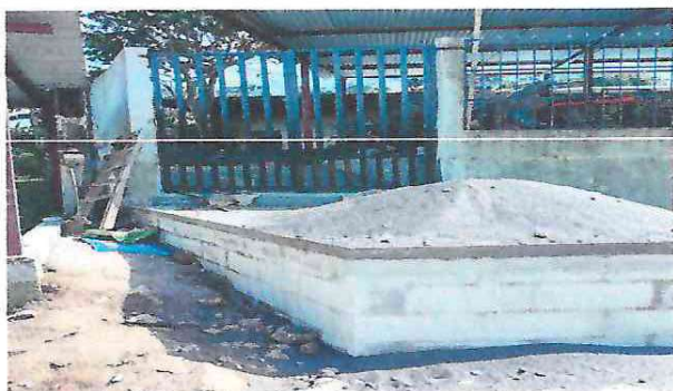
Foto 3. Mantenimiento a portón
