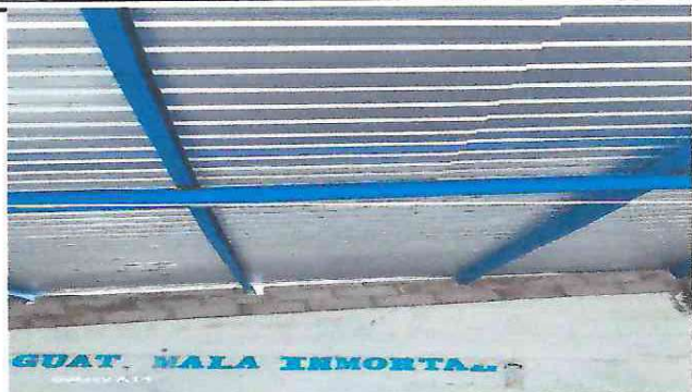
Foto 1. Cubierta de lámina
