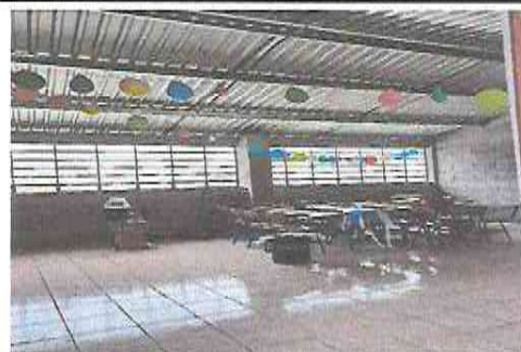
Foto 6: Sustrucción de piso.
