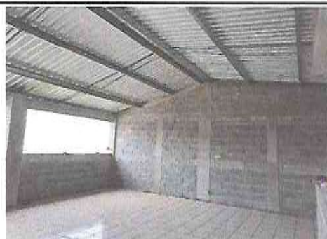
Foto 4: Sustrucción de ventanas.
