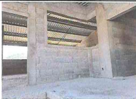
Foto 3: Reparación de muro perimetral e impermeabilización de losa.
