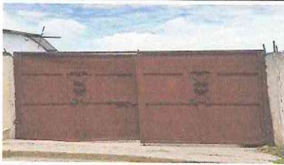
Foto1: Sustrucción de puerta principal acceso de párvulos.
