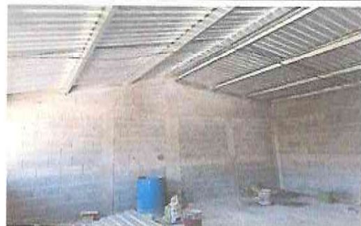
Foto 6: Sustrucción de piso.
