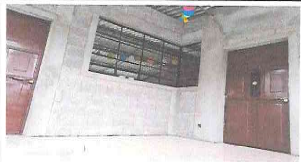
Foto 4: Sustrucción de ventanas.
