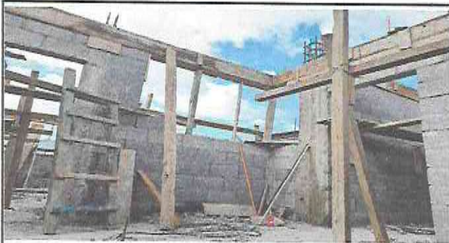
Foto 3: Reparación de muro perimetral e impermeabilización de losa.
