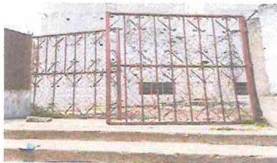
Foto 1: Sustrucción de Puerta Principal acceso de Párvulos
