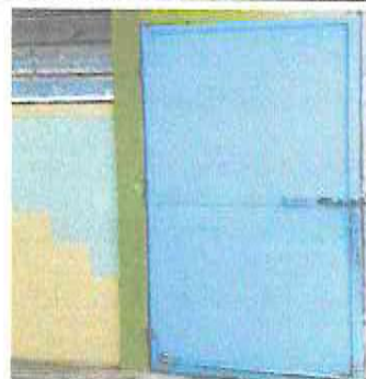
Foto 2: Sustrucción de Puertas de Párvulos
