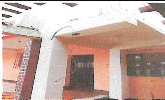
Foto 2: Vista por debajo del descanso de gradas al segundo nivel
