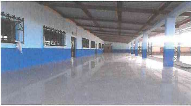
Foto 1: AULAS Y CORREDOR CON PISO CERAMICO
