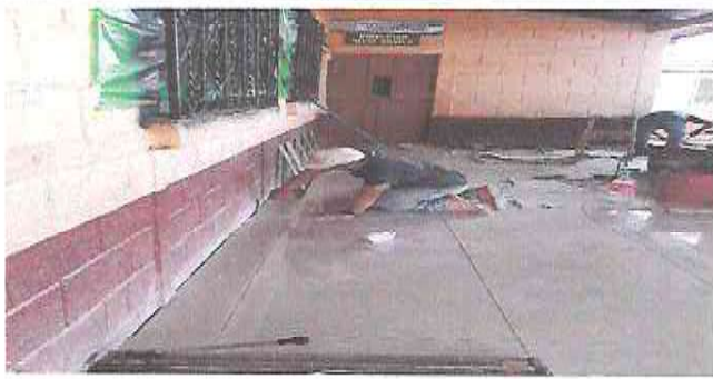
Foto1: COLOCACION DE PISO CERAMICO EN CORREDOR
