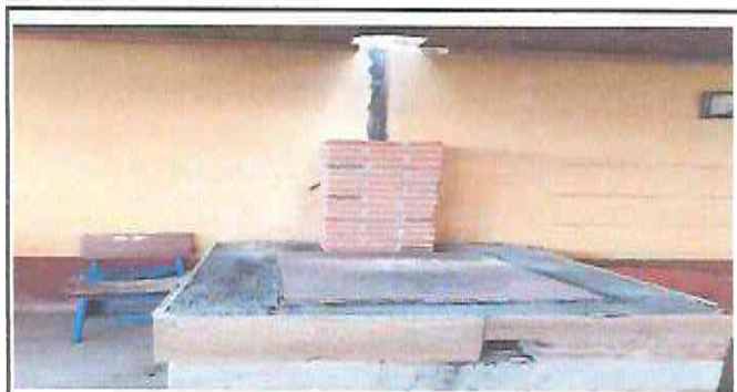
Foto 4: COLOCACION DE LADRILLO EN CHIMINEA
