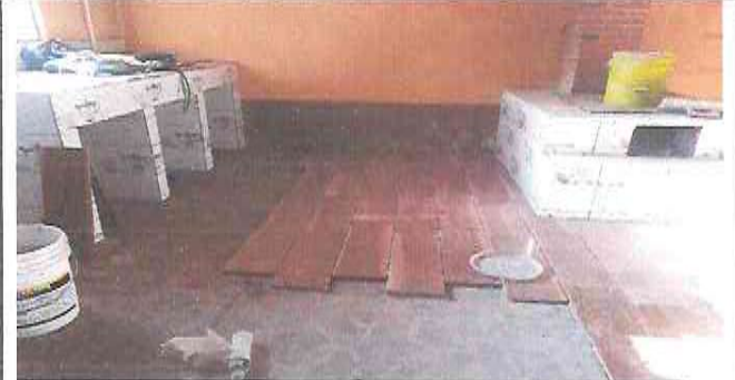
Foto 2: COLOCACION DE PISO CERAMICO ANTIDESLIZANTE EN COCINA
