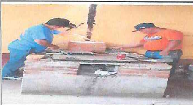
Foto 3: MEJORAS DE PLANCHA Y COLOCACION DE AZUJELO
