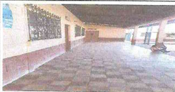
Foto1: CAMBIO DE PISO
