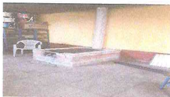
Foto 4 REMODELACION DE CHIMINEA
