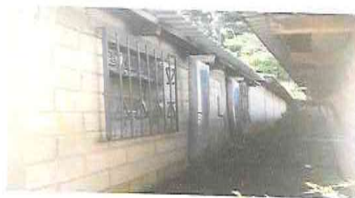
Foto 4: Reparación de balcón
