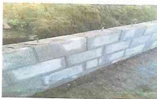
Foto 2: Elaboración de un pequeño muro de contención
