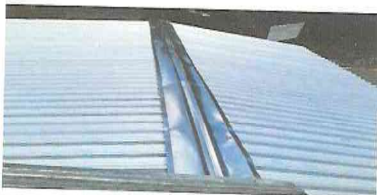
Foto1: Sustitución de techado de la cocina
