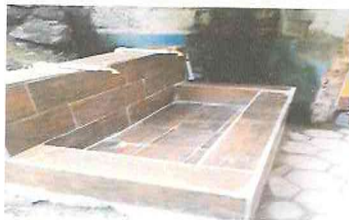
Foto 1: Instalación de dos chorros para lavar trapos
