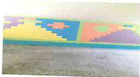
Foto 5: Pintado interior de las aulas
