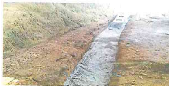
Foto 2: Elaboración de pequeño muro de contención
