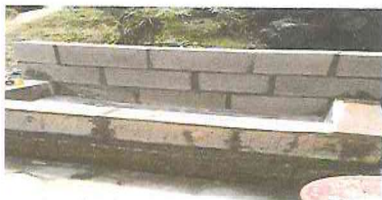
Foto 1: Instalación de dos chorros para lavar trapos
