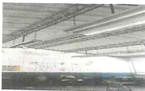
Foto 5: Pintado interior de las aulas
