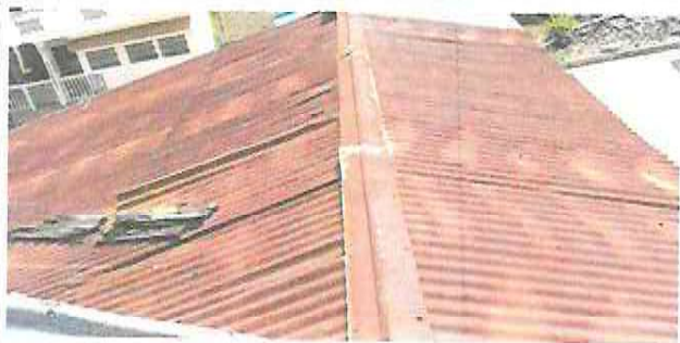
Foto 1: Sustitución de techado de la cocina
