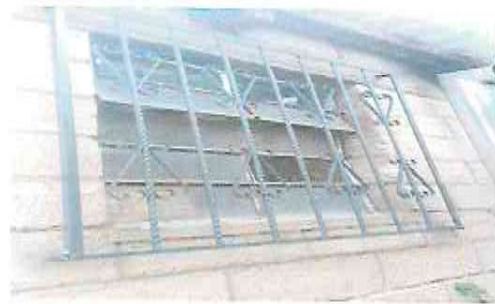
Foto 4: Reparación de balcón
