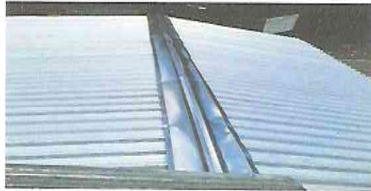
Foto 1: Sustitución de techado de la cocina
