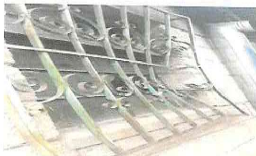
Foto 4: Reparación de balcón
