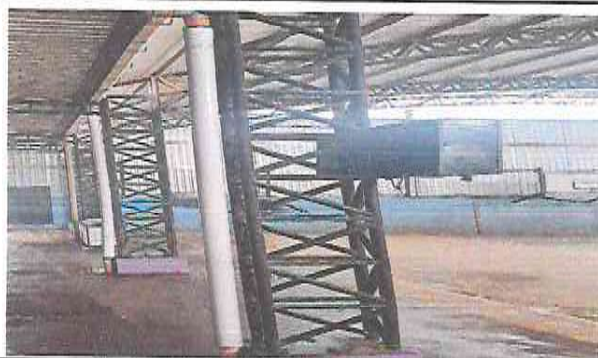
Foto 7: Reparación de bajada de agua pluvial.
