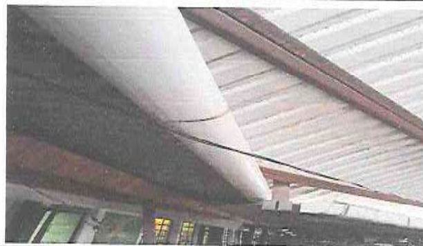
Foto 8: Reparación de bajada de agua pluvial.
