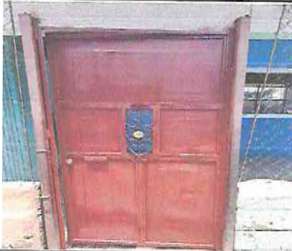
Foto 1: Sustrucción de puerta principal.
