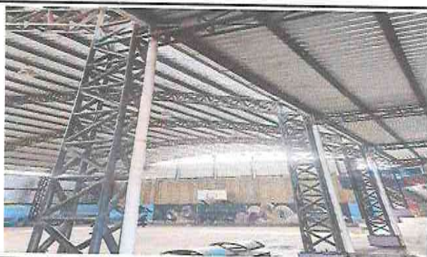
Foto 9: Reparación de bajada de agua pluvial.
