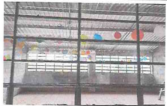
Foto 4: Reparación de muro perimetral e impermeabilización de losa.
