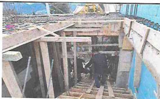
Foto 5: Sustrucción de ventana por colocación de barrandas y gradas.
