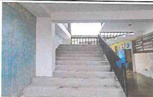
Foto 3: Sustrucción de puerta principal módulo 3 por barranda vertical y gradas
