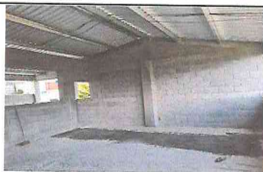
Foto 6: Sustrucción de piso.
