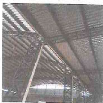
Foto 7: Reparación de bajada de agua pluvial
