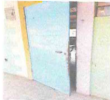
Foto 2: Sustitución de Puerta
