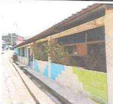
Foto 5: Sustitución de Ventanas
