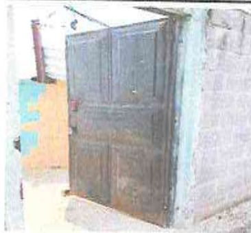
Foto 3: Sustitución de puerta Principal Módulo 3
