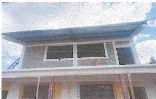
Foto 3: Obra con los ultimos detalles de trabajo
