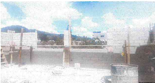
Foto 3: Vista de ventana y pared
