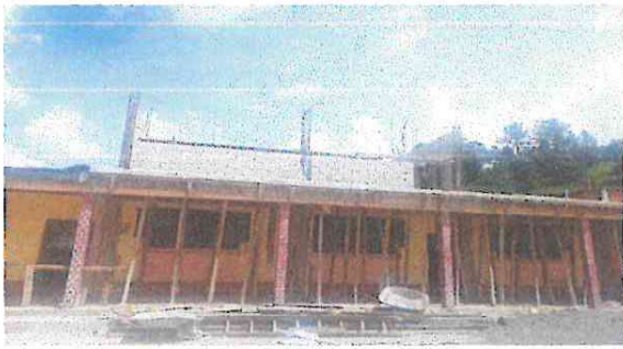
Foto 1: iniciando el aula en el segundo nivel
