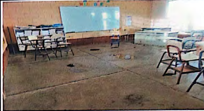
Foto 2: Aula 2, piso con torta de cemento, sexto primaria. Instalación de piso cerámico y pintada del aula interna y externa.
