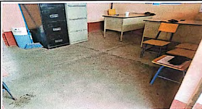
Foto 4: Dirección y bodega, piso con torta de cemento. Instalación de piso cerámico y pintada interna y externa de ambos espacios.
